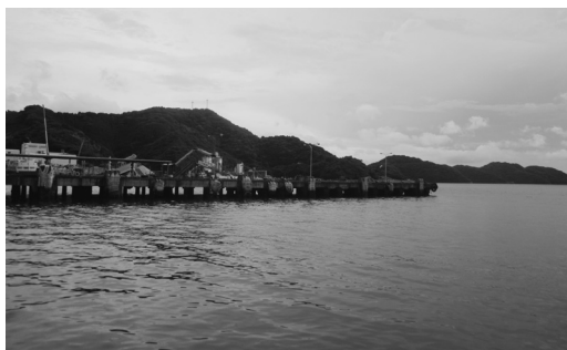
八幡浜港の様子
