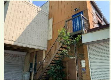
| 来ハトメ工業 本社工場
