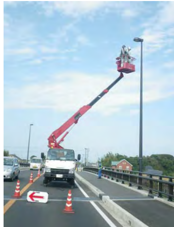
高所作業車による点検
