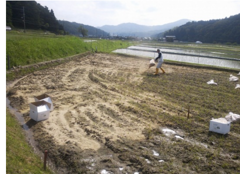
油汚染土壌浄化施工現場
