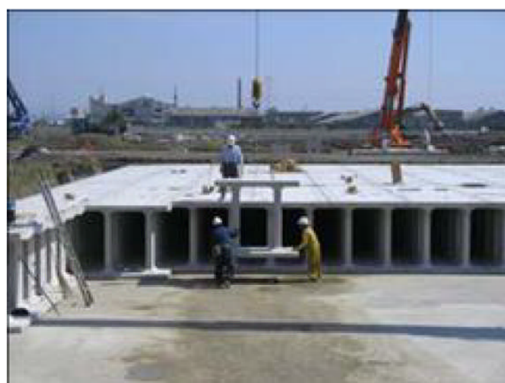
雨水地下貯留槽施工例
