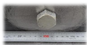
ボルト周辺部 除去
