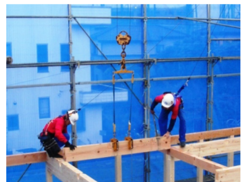
TB多能工フレイマーによる上棟作業
