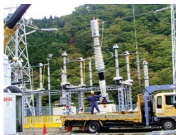
機械器具設置工事
