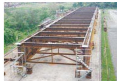
2.公共工事：鋼製橋梁上部工
