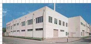
本社・第一工場
