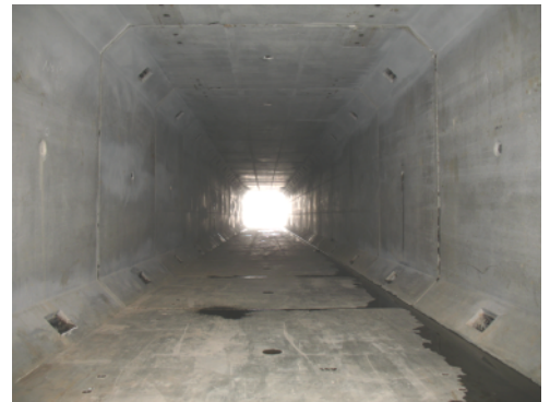
推進完了後の函路
