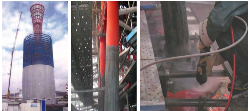
神戸ポートタワーでの試験施工例
