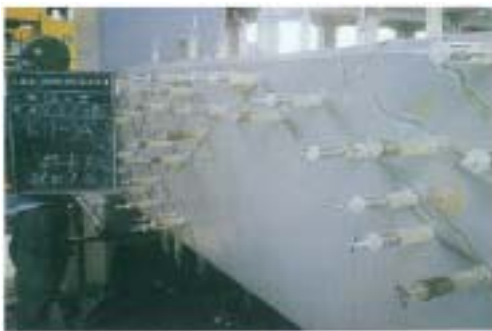
IPH工法施工状況(新幹線高架橋補修工事)
