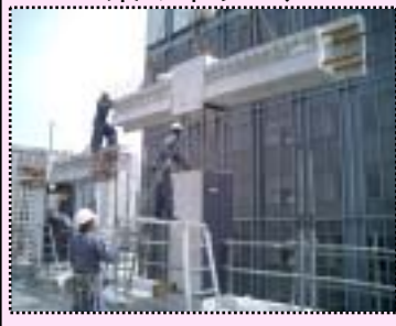
梁の吊りこみ
