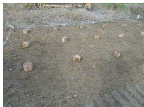
完了後の地盤表面
