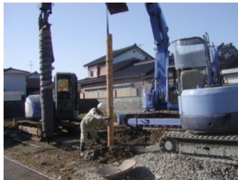
木杭打設の様子
