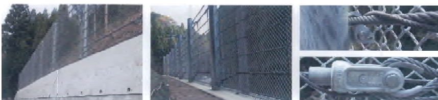
防護柵施工例
