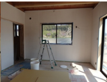
【 試作品施工後 】
