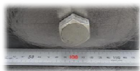
ボルト周辺部 除去
