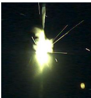
溶接時のプラズマ発生状況
