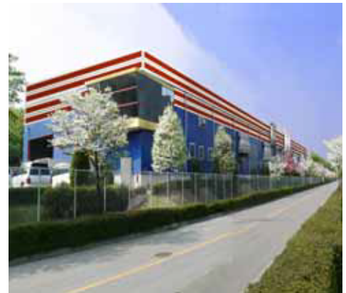
施工イメージ
