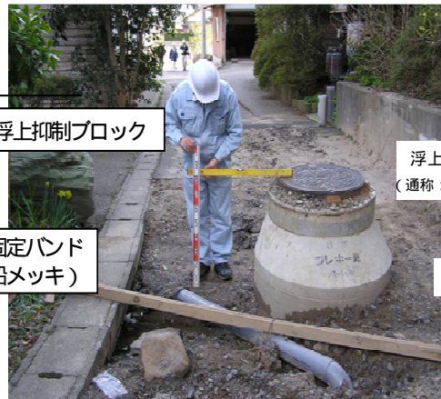
液状化現象により突出したマンホール
