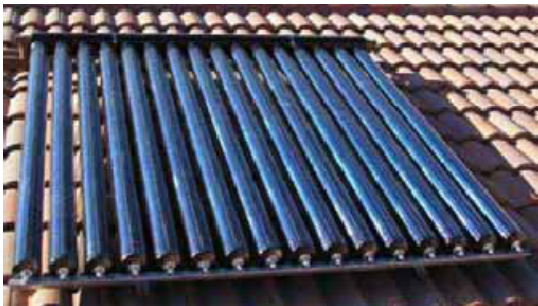
太陽光集熱器を熱源とした給湯及び床暖房システム
