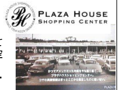
〔日本初のショッピングセンタープラザハウス〕
