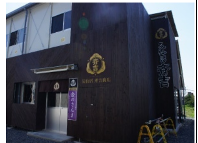
仮設の本社店舗兼工場
