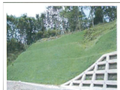
法面緑化施工
