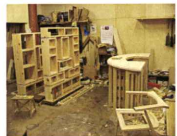
【オーダーメイドキッチン製作現場】
