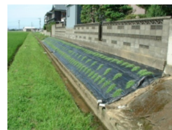
【施工 約1ヶ月後】
