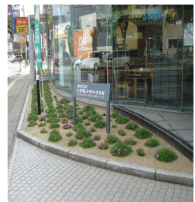
【はえん土の施工例】
