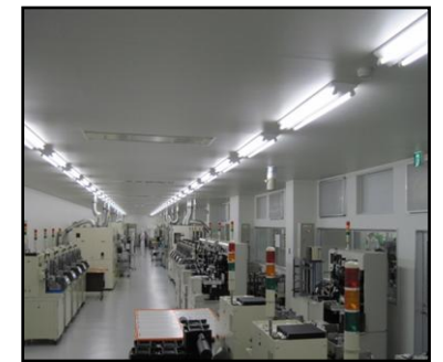
【クリーンルーム】
