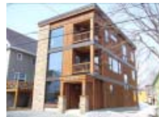
【ハル壁の施工物件】
