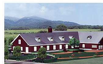
【建設中の新工場】
