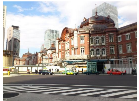
【東京駅丸の内駅舎(3階部分)】
