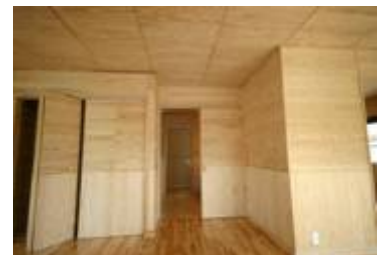
パネル工法施工例
