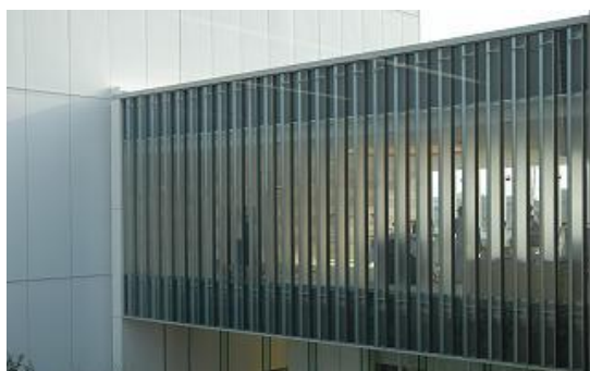
【パイオニア新川崎工場】神奈川 AE:鹿島建設株式会社
