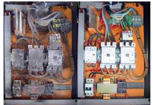
配電盤の洗浄
