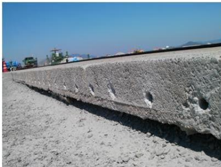
既設版削孔作業後の状況
