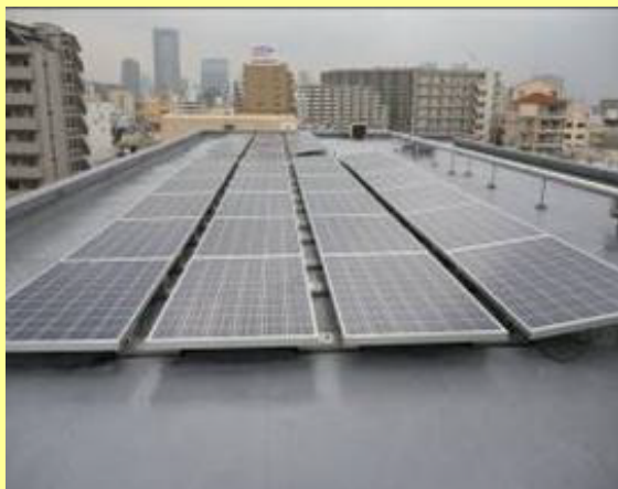
ビル屋上に設置した太陽光発電モジュール
