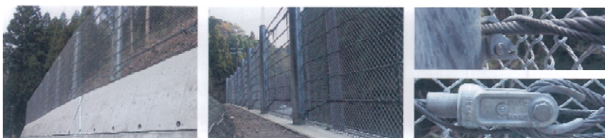
防護柵施工例
