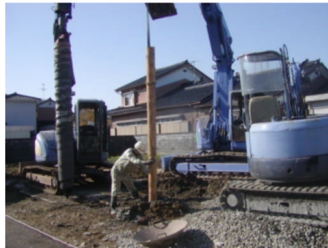
木杭打設の様子
