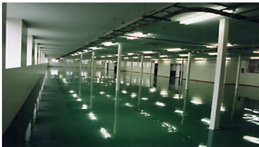
塗床施工完成例
