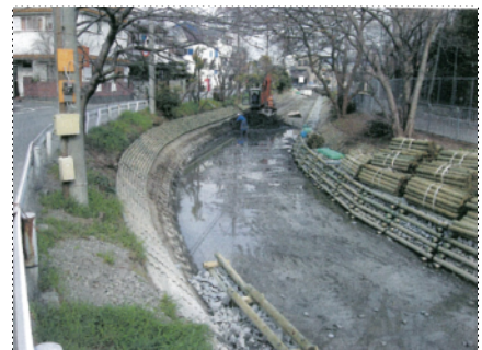
河床での施工例
