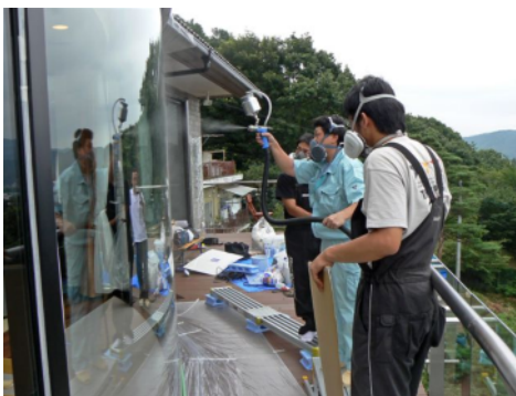
外壁ガラスへの施工状況
