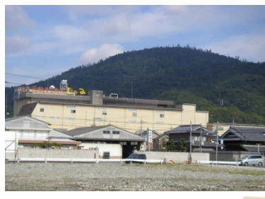
三輪山麓 巽製粉(株)工場
