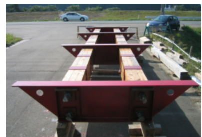
鋼製通し横桁
