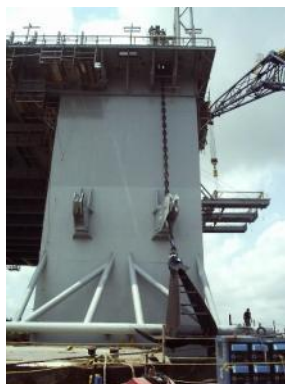
【海洋構造物に装着したチェーン】
