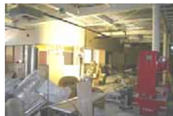
建設中の体験工房(内装)
