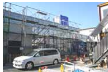
建設中の体験工房(外観)
