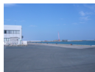
整備が進む波崎漁港
