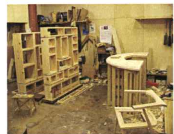
【オーダーメイドキッチン製作現場】
