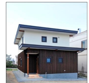
【道南スギの施工物件】
