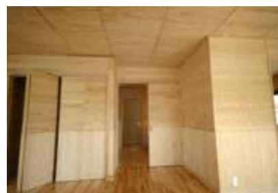
パネル工法施工例
